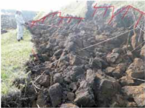
滑落崖上方の引張り亀裂
