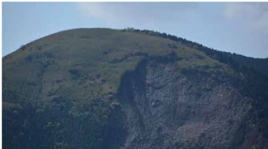
写真-3 立野大規模斜面崩壊の源頭部に残っている崩土および周囲の不安定土塊
