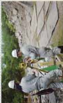
飯田丸五階櫓石垣の崩落防止工事
