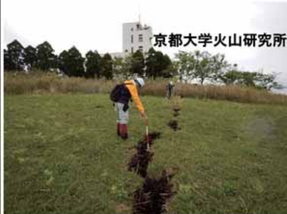
A～Dブロック斜面上方の拡大亀裂1
