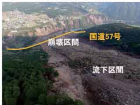
崩壊地中腹～下流俯瞰
