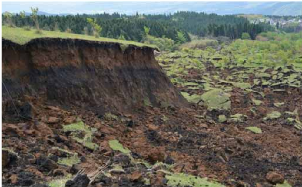
写真-5 地すべりの滑落崖、黒ボクテフラ層が認められる。
