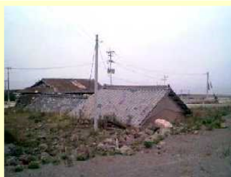
水無川からあふれた土石流による家屋の被害状況
