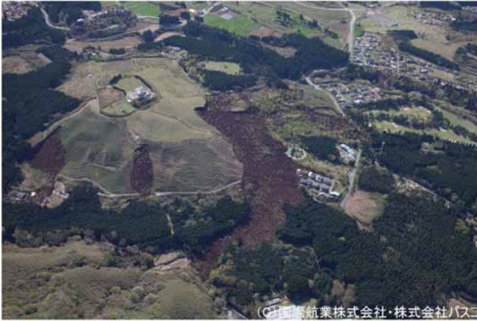
写真-4 高野台地区付近に発生した土砂災害（国際航業株式会社・株式会社バスコより）
