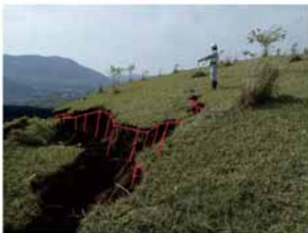
頭部滑落崖から延伸する亀裂
