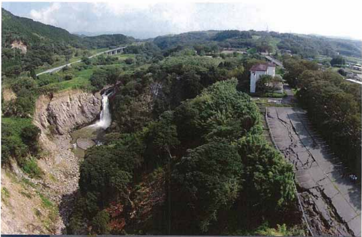
大学へ登る駐車場側の崖の崩落(上り方向)
