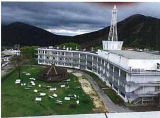
建物の真ん中を亀裂が通っている
