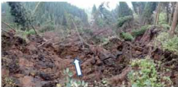
斜面中腹の被災状況
