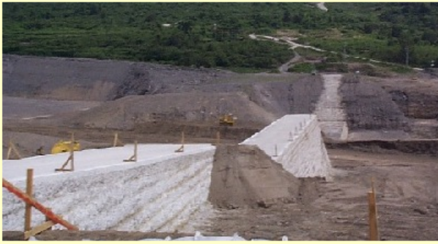
無人化施工による水無川2号砂防ダムのRCC工法施工状況
