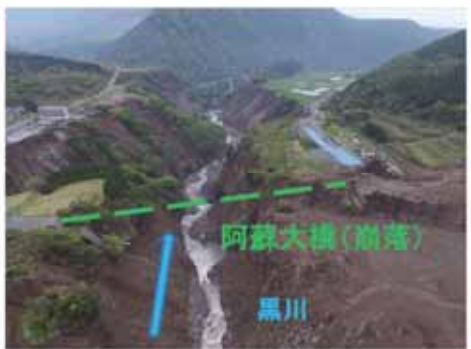
黒川溪岸崩壊 阿蘇大橋(崩落)より下流
