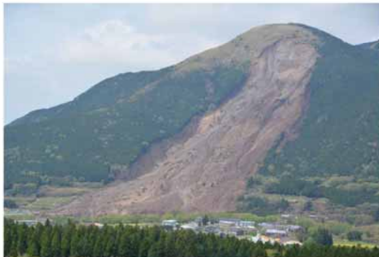
写真－2 立野地区阿蘇大橋の西側の斜面において発生した大規模斜面崩壊（立野大規模斜面崩壊）
