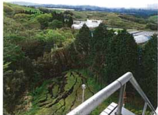
研究棟の裏側で崩落
