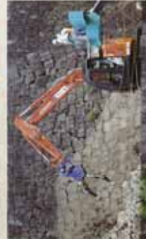
飯田丸五階櫓石垣の崩落防止工事
