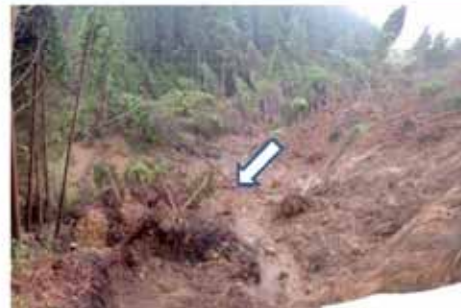
斜面中腹の被災状況
