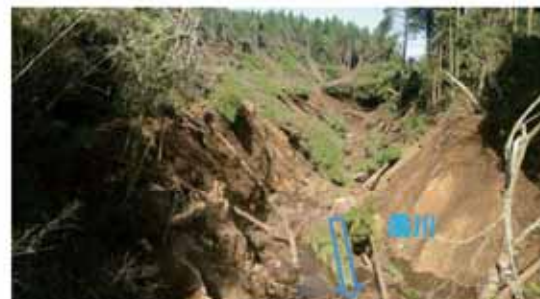
一級河川 濁川の閉塞状況 (※後日侵食により堆積土砂の多くが流出)
