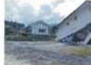
被災家屋（黒川区）
