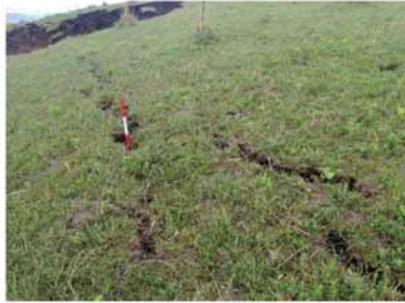
A～Dブロック斜面上方の拡大亀裂2
