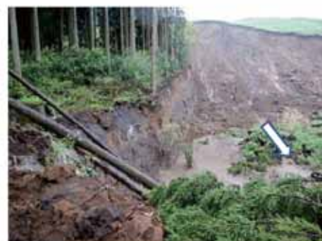
右岸側壁状況
