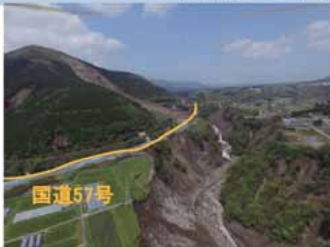
国道57号路体流出
