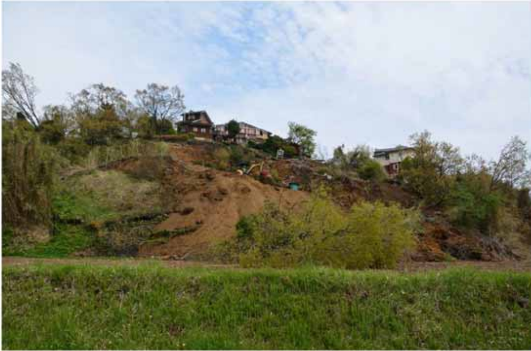
写真-8 沢津野地区の地すべり（滑落崖に円弧すべり面が露出しています）と斜面の上に立てられた家
