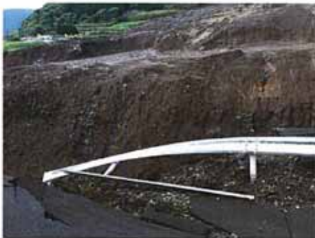
川の大学側の駐車場:一部崩落状態(対岸に橋の付け根が見える)
