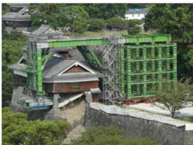
飯田丸五階櫓の倒壊防止工事。大林組による修復工事。
