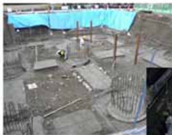
杭径1.8m×長さ11.4m 杭柱頭処理完了 GL-2.9m
