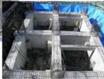
幅1.0m×梁高2.6m 地中梁完成 スパン10m×12m
