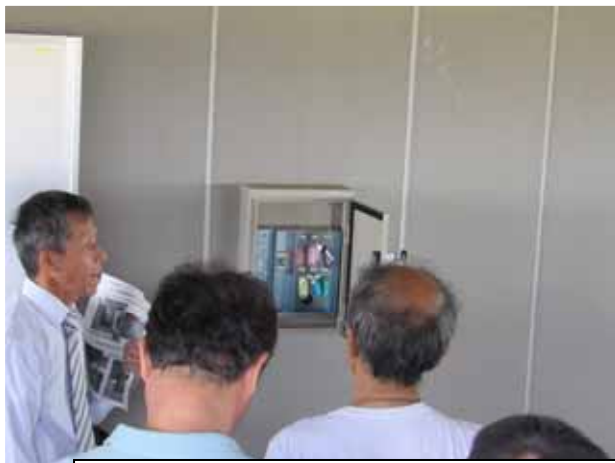
中土佐町の津波避難タワーと同じく、震度5以上で自動解錠する鍵収納ボックス
