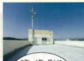
屋上避難スペース
