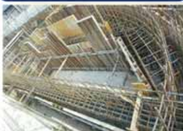
楕円形で津波の力を分散させ、また構造的にも揺れや津波に強い建物としています。
